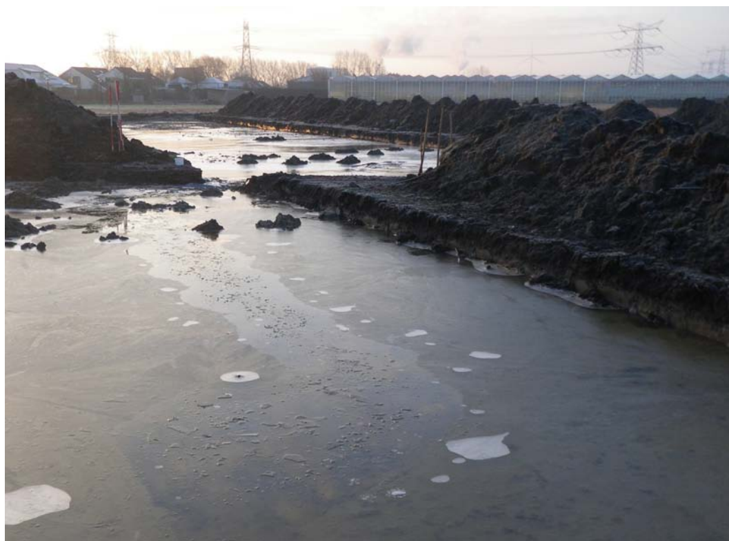
Afb. 2.2 Onderwater gelopen en bevroren werkputten tijdens het onderzoek.
